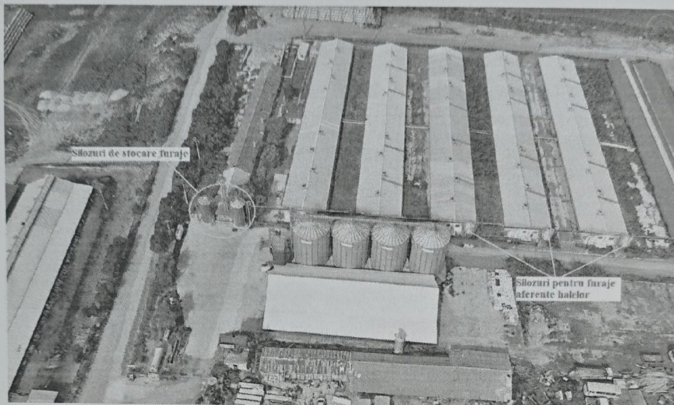
Fig.7 – Sistem exterior de stocare furaje
